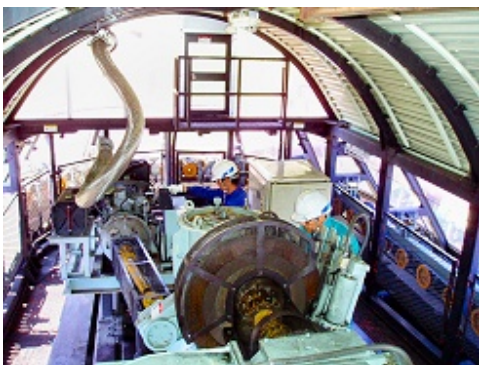
◆リフト用予備原動機の操作訓練の様子 (H18.11.20)
